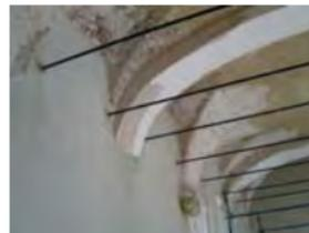
Fig.9 - Reforço de estrutura abobadada, por meio de atramentamento.
