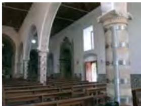
Fig.8 - Reforço exterior de colunas portantes em pedra, por encamisamento metálico.
