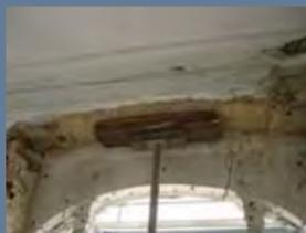
Fig.2 - Escoramento provisório de arco de vão exterior, fendilhado no fecho por descompressão (afastamento das nascenças).
