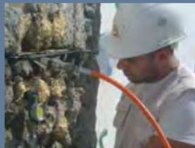
Fig.3 - Aferição do estado de tensão instalado em parede resistente de alvenaria, por introdução de macacos planos.
