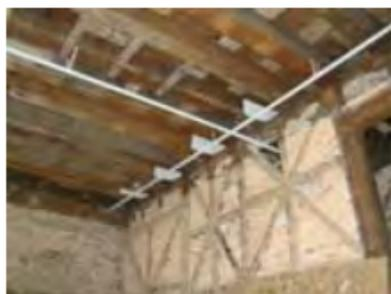
Fig.10 - Aplicação de sistema de reforço atirantado em edifício em gaiola pombalina.
