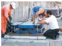
Fig.13 - Pormenor de instalação de isoladores pendulares.
