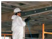
Fig.9 - Injecção de chapas de reforço com resina de epóxi.
