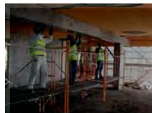
Fig.11 - Reforço da estrutura com laminados de fibras de carbono.
