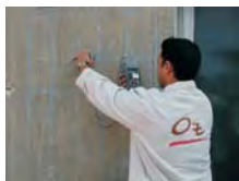
Fig.5 - Detecção de armaduras e medição do recobrimento.
