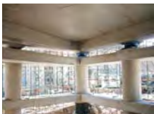
Fig.12 - Instalação de isoladores pendulares no museu New Acropolis, Atenas.
