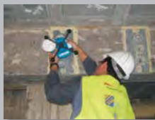
Fig.4 - Ensaio de arrancamento para avaliação da aderência das chapas de reforço ao betão.
