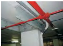
Fig.10 - Reforço da estrutura com perfis metálicos.
