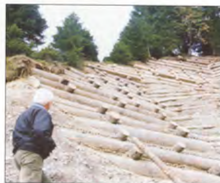
ESTABILIZAÇÃO DE TALUDES
