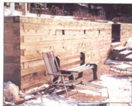
MUROS DE MADEIRA
