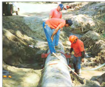
ANCORAGEM DE "PIPELINES"
