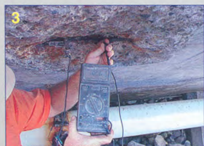
Figura 1 - Corrosão num cais.
