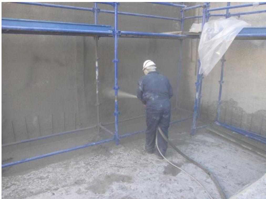
Projeção da 1ª camada de matriz cimentícia, aplicada por **via seca** com máquina de câmara dupla – *sprayed concrete*.
