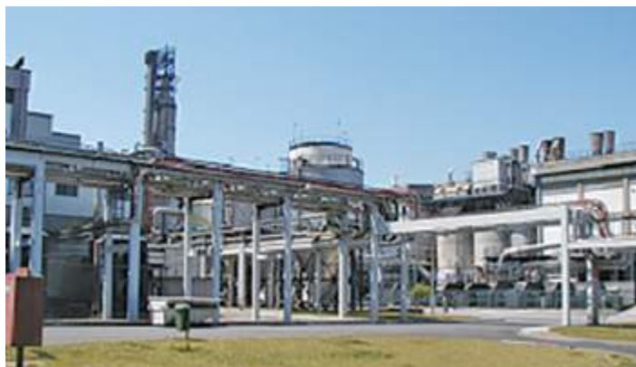
Aspeto geral de uma frente de trabalho
