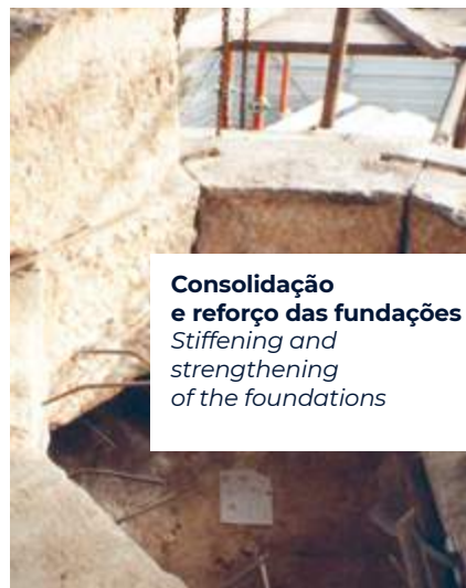
Execução das micro-estacas Execution of micro-piles
