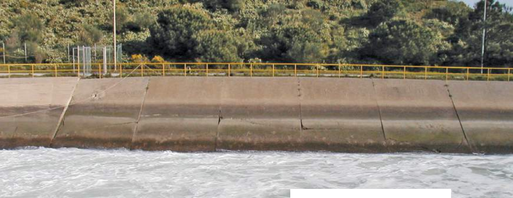
Fenda horizontal nos painéis de revestimento da margem esquerda Horizontal cracks in the cover panels of the left bank
