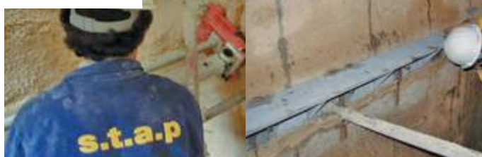
Projeção de argamassa, malha de fibra de vidro e pontos de injeção
