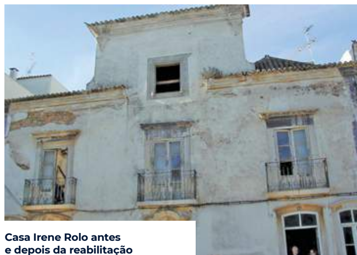
Vista global das obras de reabilitação Global view of the rehabilitation works
