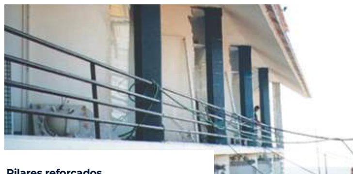
Pilares reforçados Reinforced pillars
