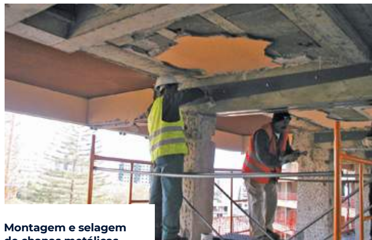
Aplicação de laminados de carbono Application of carbon laminates
