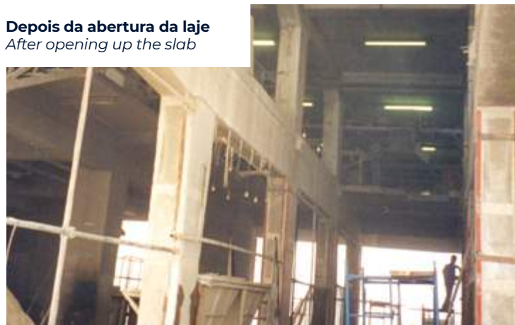
Corte da estrutura de betão armado Cutting of reinforced concrete structure
