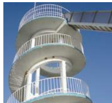
Aspeto do betão projetado View of applied sprayed concrete
