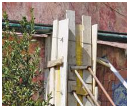
Cofragem de contraforte Buttress formwork
