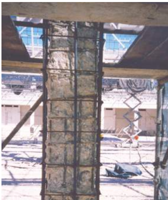
Vista geral dos trabalhos de reabilitação Global view of the rehabilitation works
