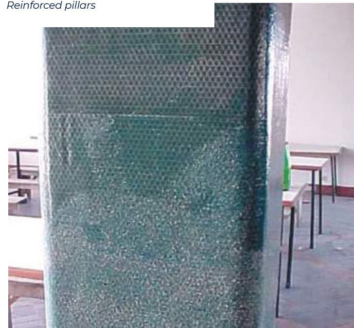
Pilares reforçados Reinforced pillars
