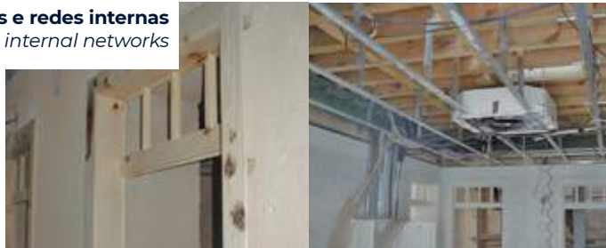
Estrutura de madeira apoiada em estrutura metálica – Pavimentos e Coberturas Timber structure supported on metal structure - Floors and Roof
