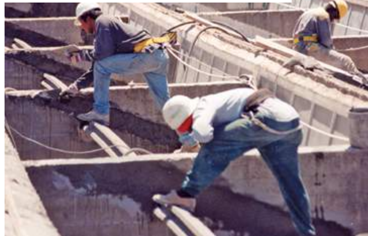
Injeção de resina de epóxido em reforços estruturais Injection of epoxy resin for structural reinforcement
