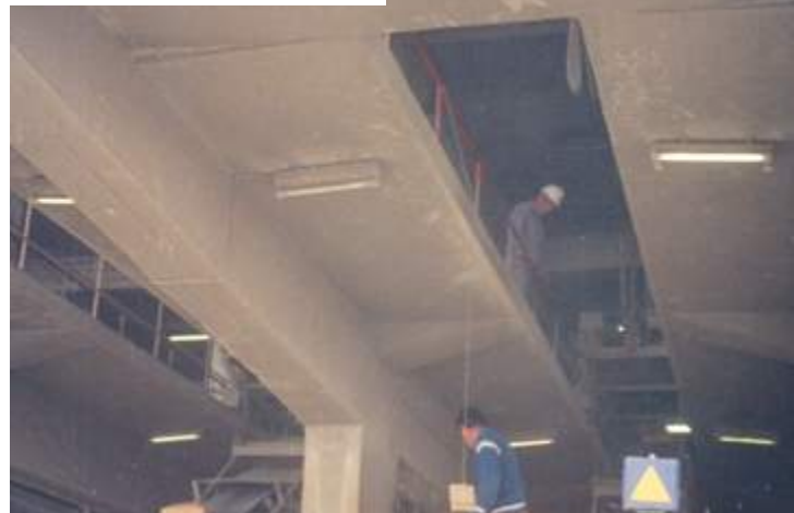
Depois da abertura da laje After opening up the slab
