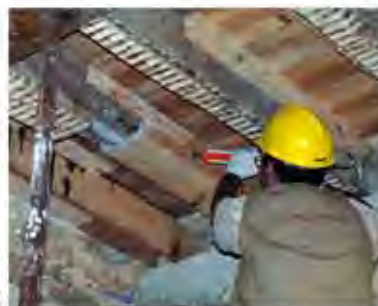
Fig. 3, 4 e 5 - Instalação de tirantes de contraventamento Fig. 6 - Reparação localizada de um pavimento de madeira
