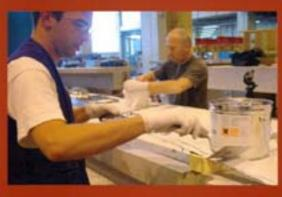
Colocação e fixação da chapa metálica na extremidade da ancoragem fixa.
