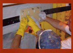
Colocação e fixação do "Kit de Pré - esforço" na extremidade da ancoragem móvel.
