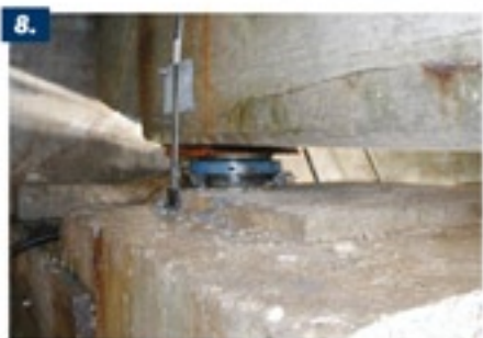
8. Levantamento de tabuleiro para substituição de aparelhos de apoio
