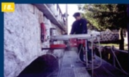
18. Furação para atirantamento de uma ponte de alvenaria de pedra
