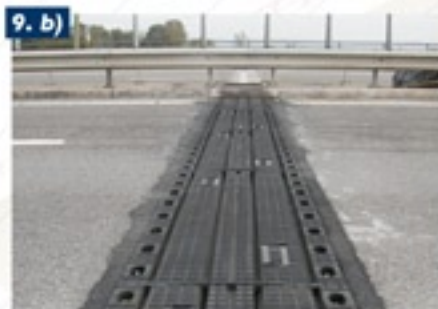
9. Substituição e reparação de juntas dilatação a) Remoção da junta deteriorada b) Junta nova, acabada de montar
