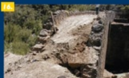
16. Reconstrução de uma ponte medieval
