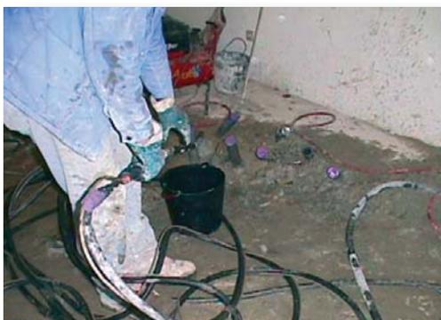
Injeções de caldas de cimento ou de resinas hidroativas em solos.
