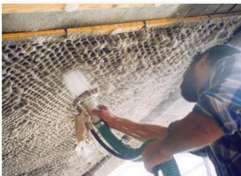
Dessalinização electroquímica de uma estrutura de betão armado contaminada com cloretos. Proteção do electrólito, constituído por uma pasta de celulose embebida.
