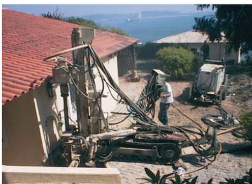
Execução de microestacas para reforço da fundação de um edifício
