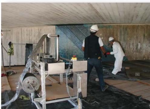
Reforço por aplicação de laminados de fibras de carbono.
