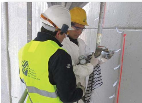
Injeção de resina de epóxico numa parede de betão fissurada.
