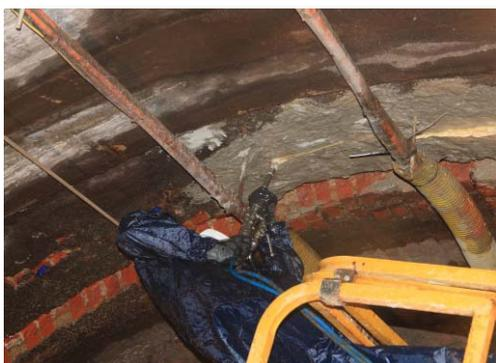
Injeção de resina hidroativa (poliuretano) para estancamento de fugas de água.
