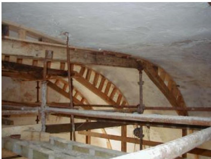
Figura 16 – Escoramento da abóbada
