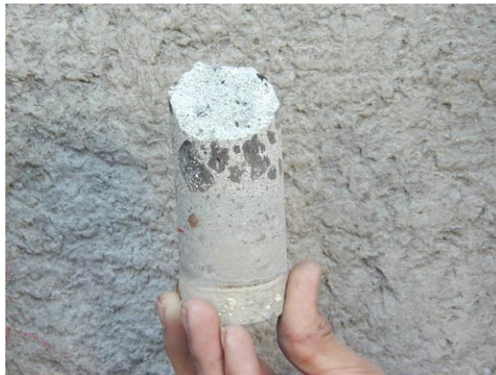
Figura 3 – Carote de betão projectado após ensaio de arrancamento.
