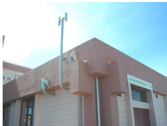
Figura 5 – Aspecto final da reparação de um edifício com betão projectado afagado e pintado.
