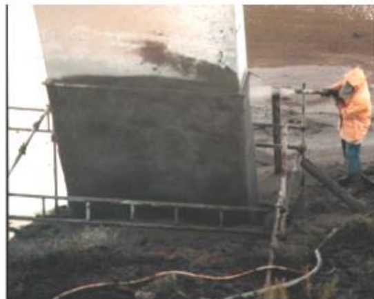
Figura 2 – aplicação de betão projectado por via seca com máquina de câmara dupla na reparação de um pilar de uma ponte.
