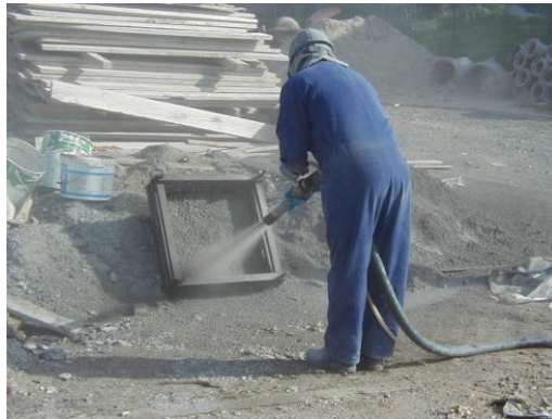
Figura 6 – Execução de painel de ensaio.
