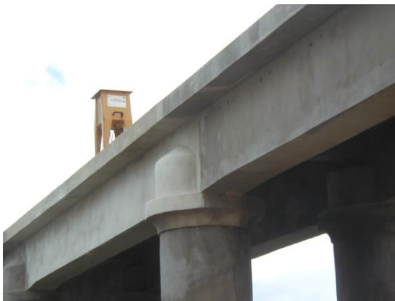
Figura 4 – Aspecto final da reparação de uma ponte-cais com betão projectado
