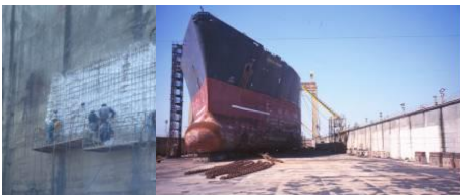
Figuras 19 e 20 – A dificuldade executiva da obra 7, na remoção e aplicação do betão
