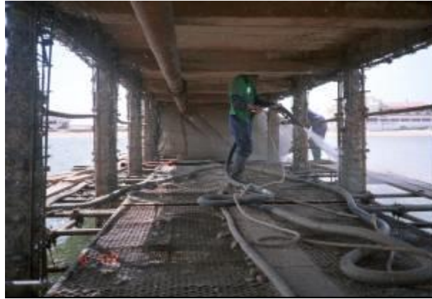
Figuras 16 e 17 – Sistema de reforço da obra 6
