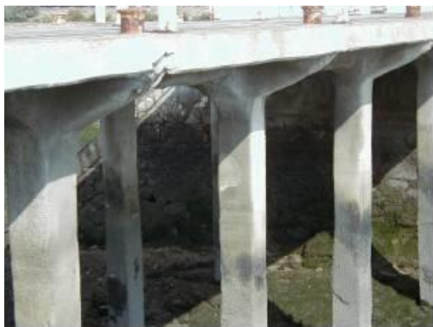
Figura 30 – Aspecto actual da obra 5 (2000)
