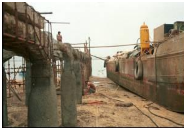
Figuras 11 e 12 – Demolição de lajes e pormenor da ligação viga - laje
