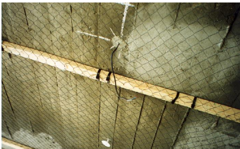
Figura 4 – Instalação do ânodo.
