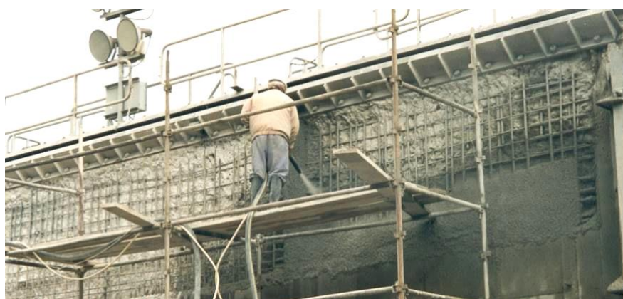
Figura 5. Reparação da paredes.
